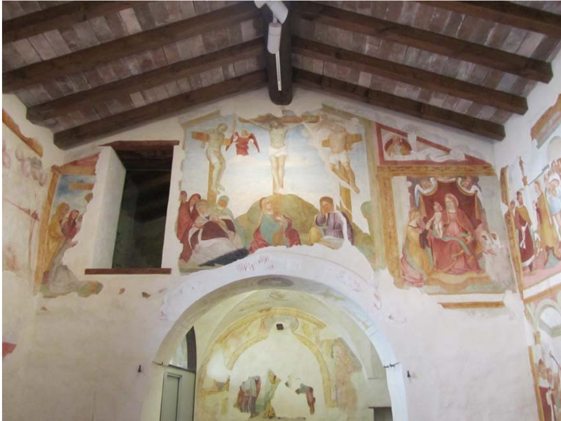
Plafond avec poutres neuves et planelles de terre cuite encore à l'ancienne.
